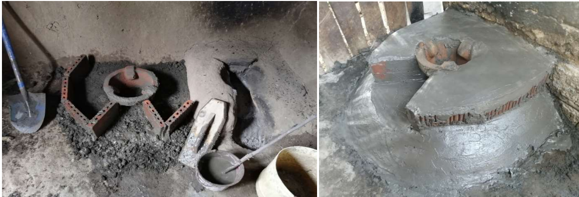
Abbildung 4; Die Endstufen und das Endprodukt, eine brennstoffsparende Kocheinheit
