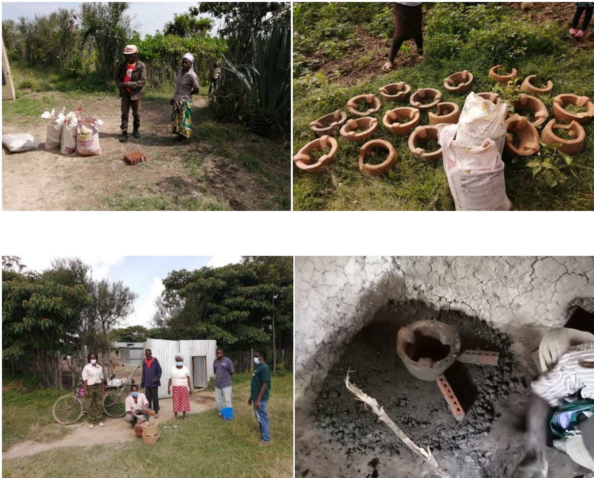
Abbildung 3; Lieferung von Baustoffen an das Haus eines Begünstigten und erster Schritt der Ziegelverlegung
